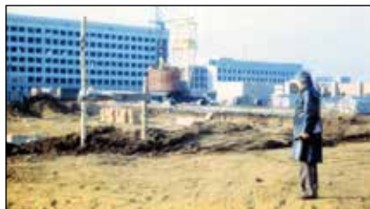
В.Н. Канюков на краю котлована
